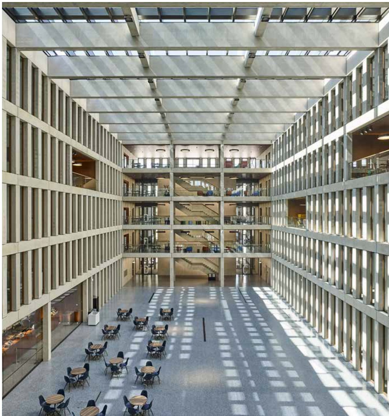
Le bâtiment administratif «Guisanplatz 1b» à Berne est certifié SNBS 2.0 Platine, Minergie-P-ECO et Bon climat intérieur. (Photo : Rolf Siegenthaler)
